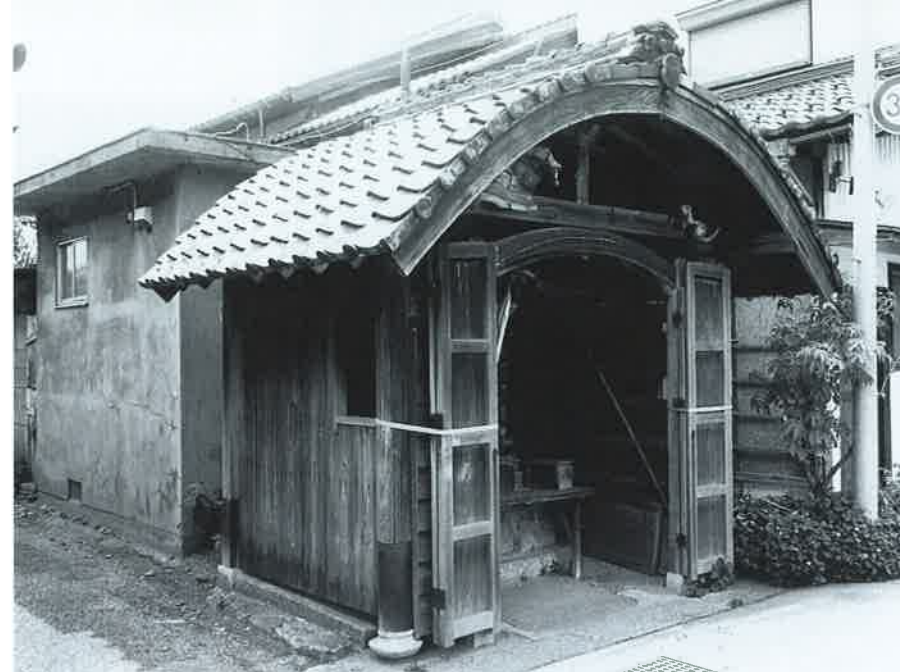
▲北国街道に面して建つ旧曾根学校の玄関。中にお地蔵さんが祀られている
