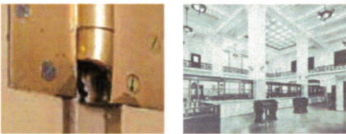
旧日銀地下金庫の扉はエレベーターホールを抜けてきた爆風により破損している。当時の日銀1階。ここを他銀行が間借りをし、市民に対応した。
