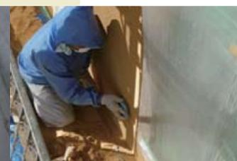
表面をブラシで掻き落とし、「人造石掻き落とし仕上げ」の作業
