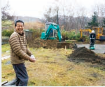
レティエの側に建設中の「自給のむら」。建設費は久世さんや協賛してくれる有志が持ち出して負担している。
