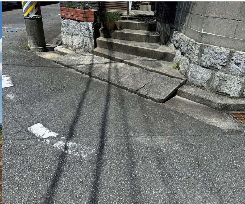
岡崎市明大寺町茶の木原義路。4段の階段で1mほど上がっている。
