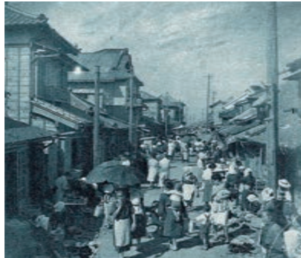
松の家が面する「旧市役所通り」。昭和初期頃の様子。 (写真：小林写真館 小林保)
